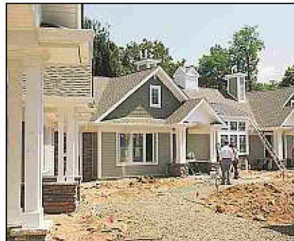
Orchard Commons construction.
